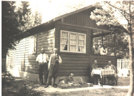
Kranichweg 43: Das Gartenhaus wurde 1929 gebaut und musste 1937 einem Steinbau weichen
