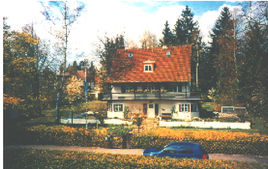
Birkhahnweg 15: Das Haus wurde 1928/29 gebaut. Die Aufnahme ist von 2000
